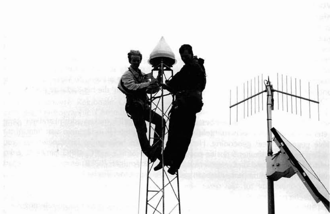
Figuur 4. Montage van de antenne op het AGRS.NL-referentiestation in Eijsden.
